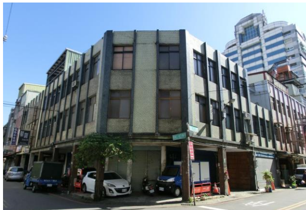
圖 20 本計畫 G09 土地開發基地老舊建物現況(1)
