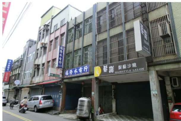
圖 21 本計畫 G09 土地開發基地老舊建物現況(2)
