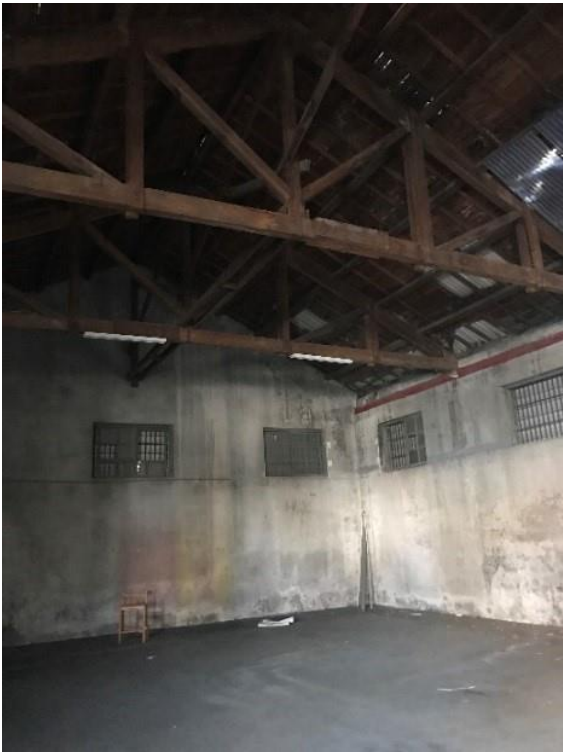
圖 35 G04-1 土地開發基地閒置倉庫現況
