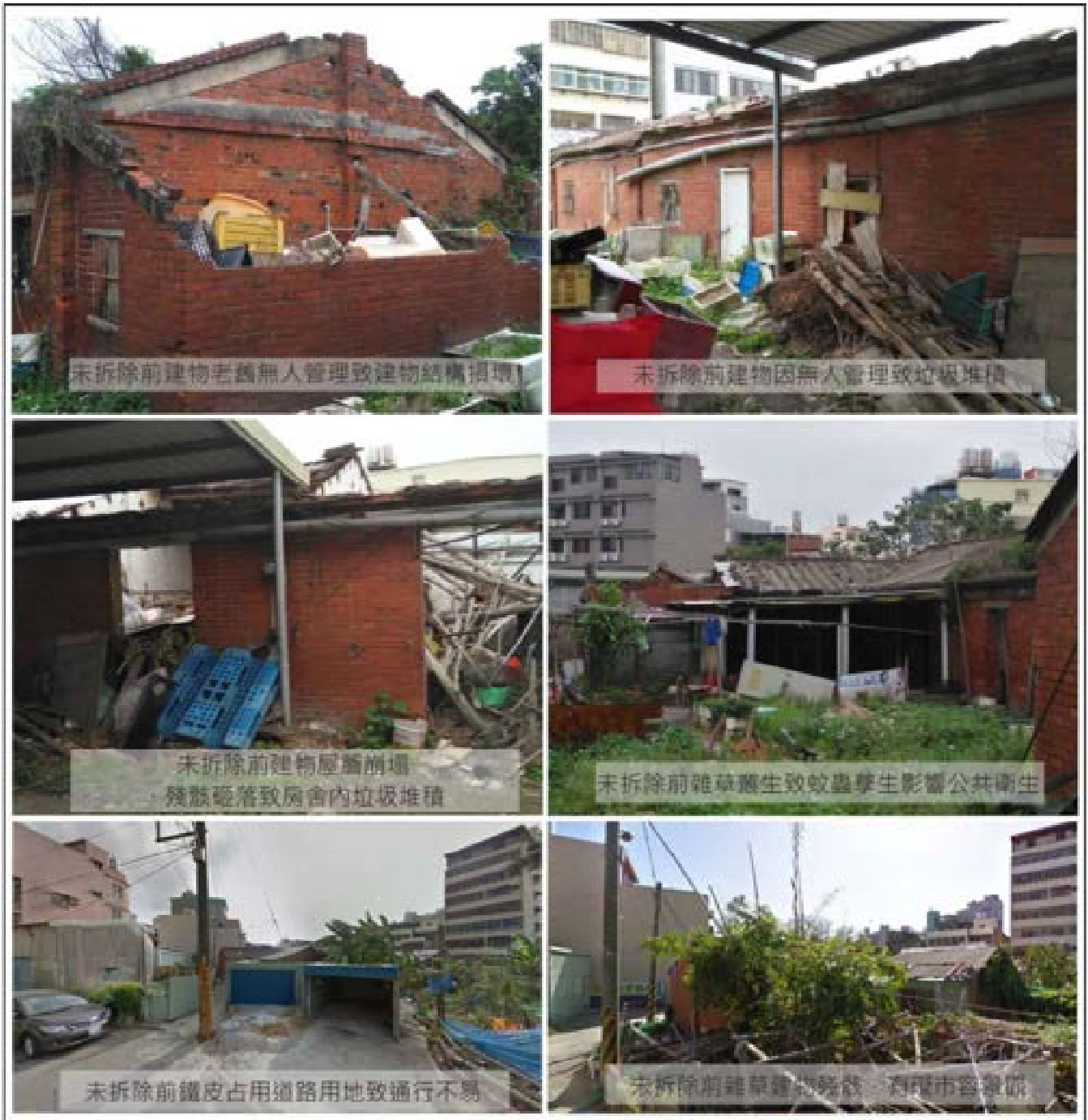
圖 3 計畫範圍內拆除前廠陋房舍實況圖
